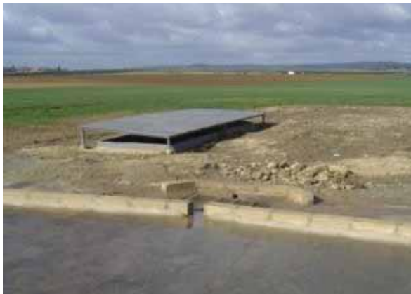
Aire de lavage : débourbeur déshuileur
